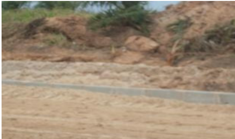
Figura 3-Obra do calçamento no balneário de Guriri , realizado pela prefeitura de São Mateus.
