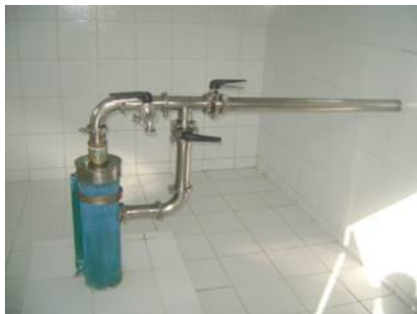
Figura 2 – Imagem do poço construído.
