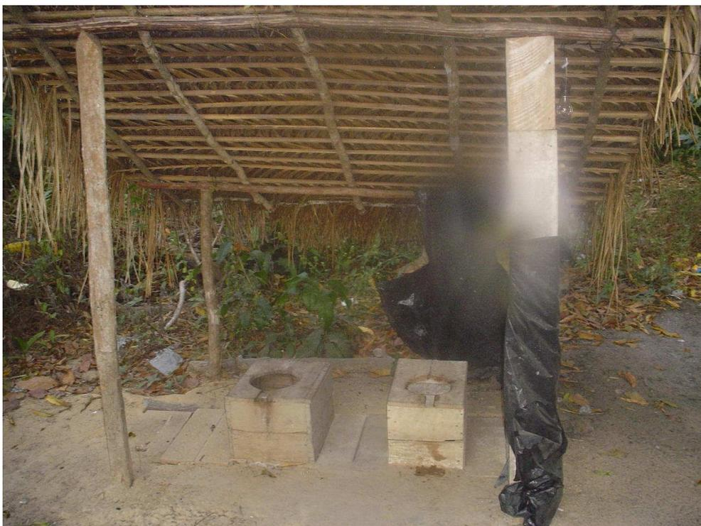
Fig. 7: Sanitários recobrando fossa escavada, sem revestimento que impeça infiltração da matéria orgânica decomposta no solo.
