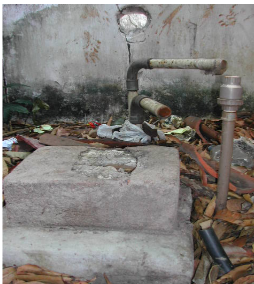
Figura 05 - Poço nº 30 (Entrada do Campus do Pici), onde são observadas as más condições de preservação e manutenção ao redor do poço. Campus do Pici, Fortaleza.
