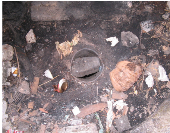
Figuras 06 e 07 - Poço n° 33 (Centro Esportivo), onde se tem o descaso com a obra de captação. Campus do Pici, Fortaleza.
