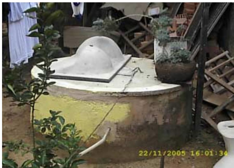
Figura 7 - Poço 41, situado na rua Bartolomeu Pereira, apresentando precárias condições de higiene, onde se identificou o teor de  $7,60 \text{ mg}/\text{l}$  de  $\text{NO}_3/\text{N}$ .
