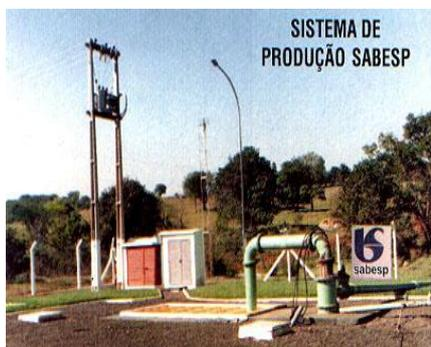
O reservatório R3 recebe água dos 13 poços, produção média de 18.000 m<sup>3</sup>/dia que recebe aplicação de flúor e cloro para desinfecção e transportada por conjuntos motobomba ao reservatório elevado T1, e distribuída para a população.
