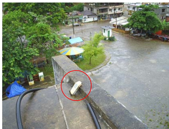
Figura 9 - CEASA em São José de Ubá – DGPS instalado para medição
