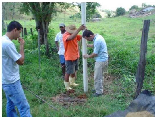
Figura 81- Implantação de poço de monitoramento em Santa Maria
