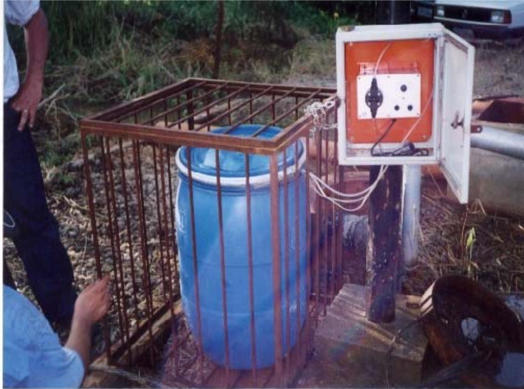
Foto – 8 Detalhe da bomba dosadora do bactericida de manutenção.
