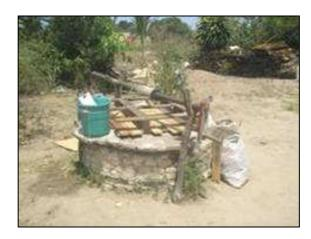
Figura 05: Construção irregular do Poço
