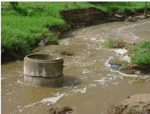
Figura 6 – Erosão verificada na Barragem Cafundó I no distrito de Mutuca - PE.
