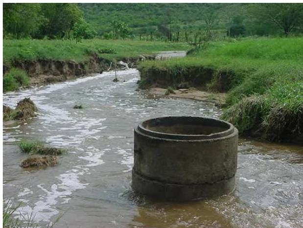
Figura 5 - Voçoroca causada pela força das águas na Barragem Cafundó I no distrito de Mutuca – PE
