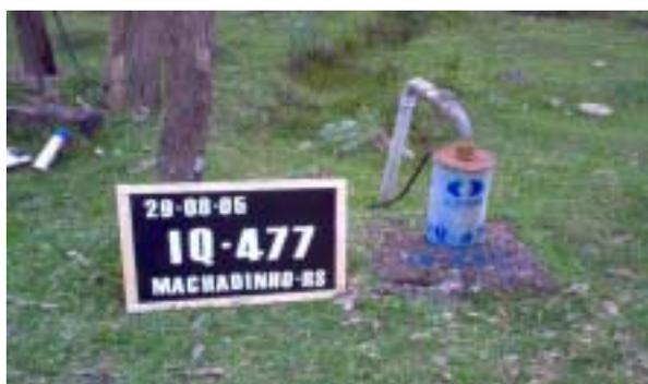
**Figura 3.** Foto de poço contendo placa de identificação e pintura da sigla no corpo do poço.
