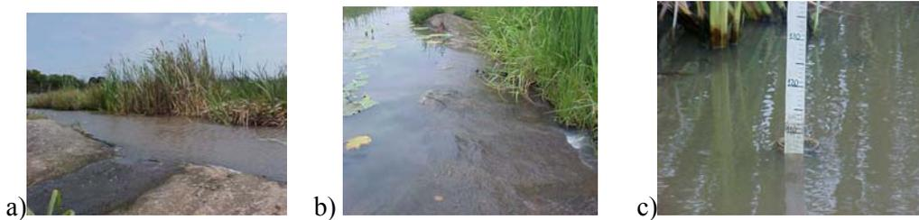
Figura 4 - Vertedor e lâmina d'água em duas datas: período seco (a), período chuvoso (b) e detalhe do linímetro (c).
