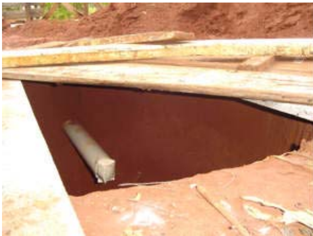
Figura 12 - Construção da Fossa Negra Fonte: Olaia, F. B. (2005)
