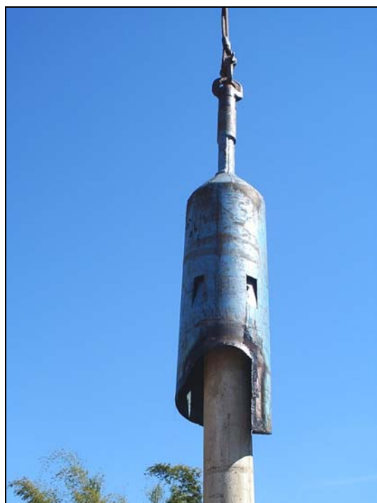
Foto 4. Pescador tipo garra retirando tubulação edutora de Ø 8”.
