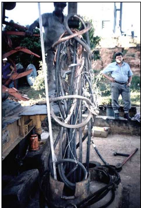
Foto 16. Pescador tipo arpão utilizado para pescaria de cabo elétrico.
