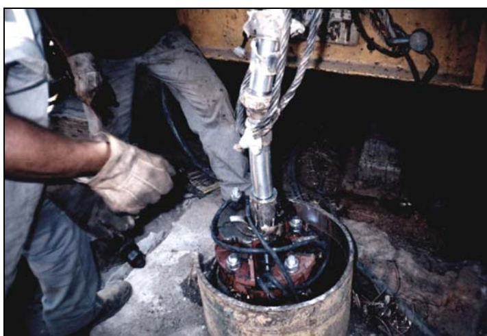
Foto 20. Detalhe do eixo do bombeador sem os rotores que quebraram com a queda.
