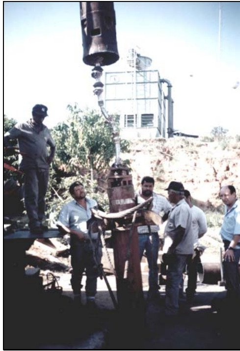
Foto 22. Retirada do motor submerso através do eixo do bombeador.
