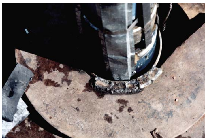
Foto 15. Bomba submersa sendo retirada após aprisionamento na coluna de revestimento.
