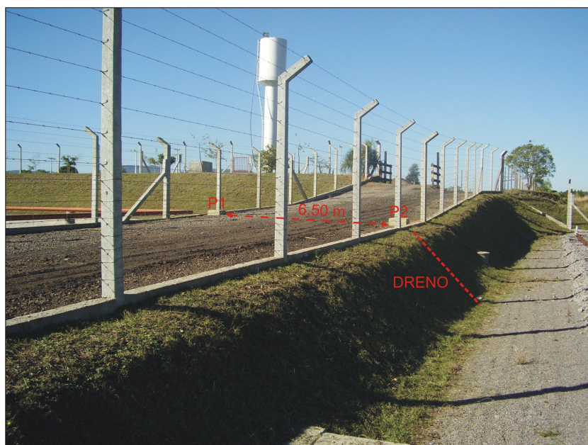
Figura 11 – Corte no terreno que serve como dreno tornando o poço P2 uma depressão potenciométrica.
