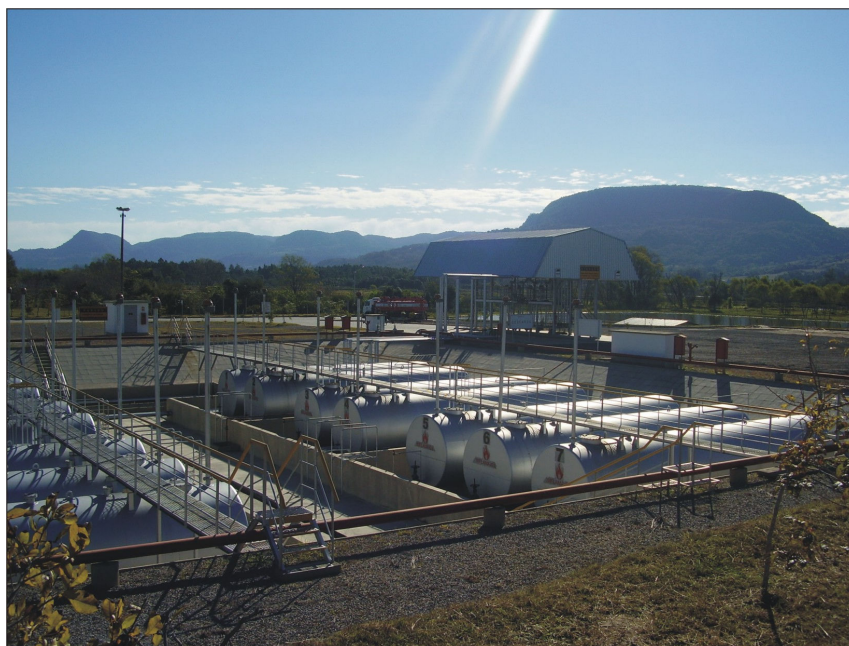
Figura 2 – Vista parcial do empreendimento e dos tanques subaéreos de armazenamento de combustíveis (tomada de Sul para Noroeste).
