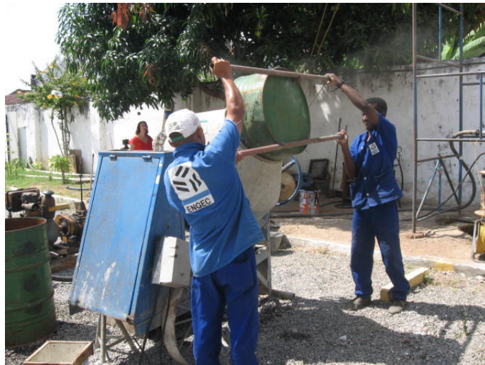
FIGURA 5 – Colocação de água na mistura dos pós
