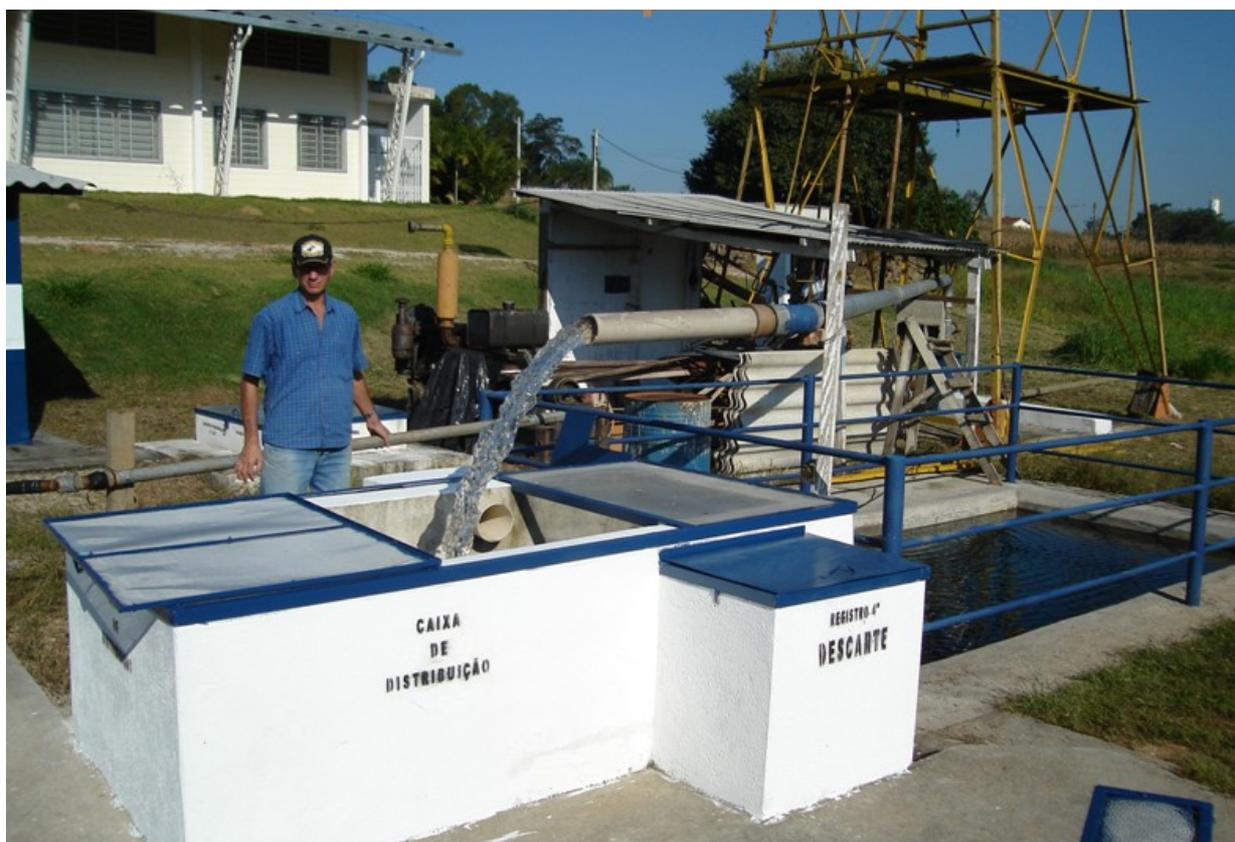
Figura 11. Lançamento de água do poço na caixa de distribuição.
