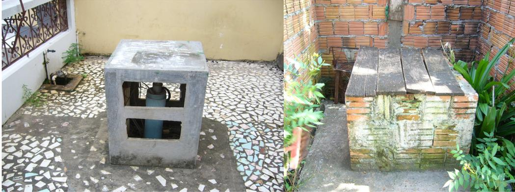
Fotos 1 e 2. Poços protegidos com caixa de alvenaria para evitar contaminação. Dez./2007
