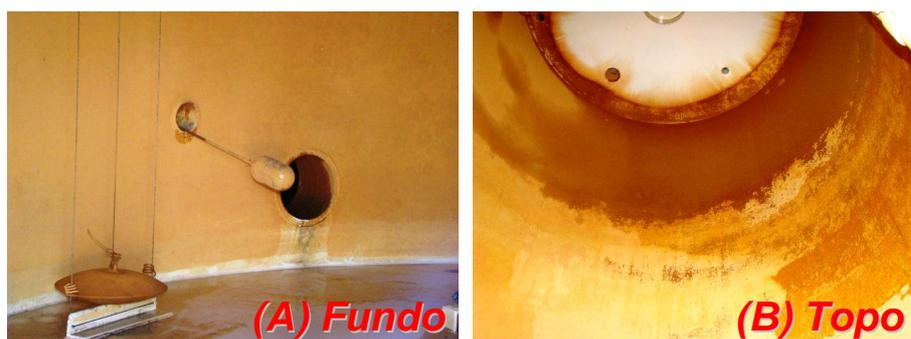
Figura 6. Material ferruginoso acumulado em um dos tanques de captação.
