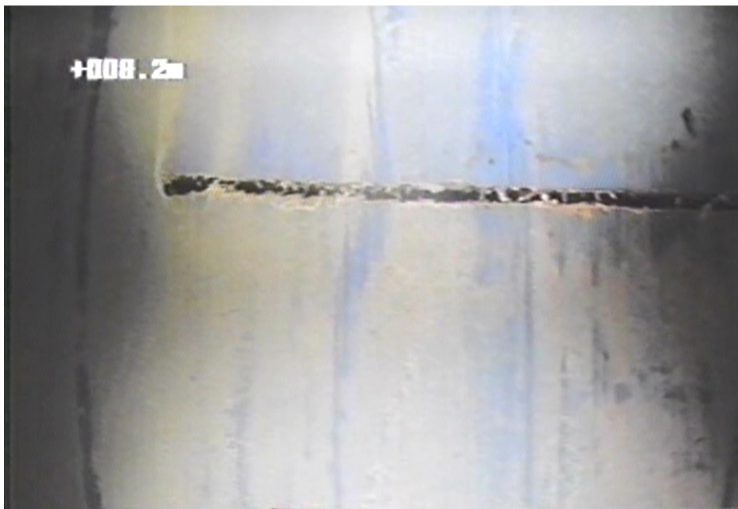
Figura 4. Imagem capturada da perfilagem ótica, visão lateral, no poço nº 4 -Fazenda Santa Fé, exibindo ranhuras feitas à serra manual na profundidade de 8,20 m.
