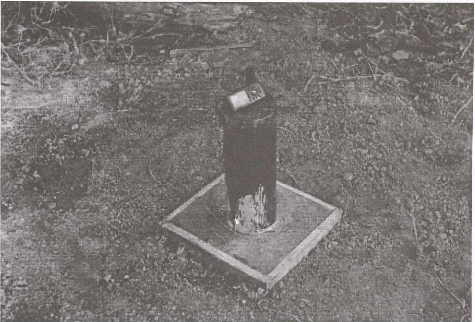
Foto 2 – Detalhe do poço de monitoramento P1 com tubo externo e tampa de ferro.
