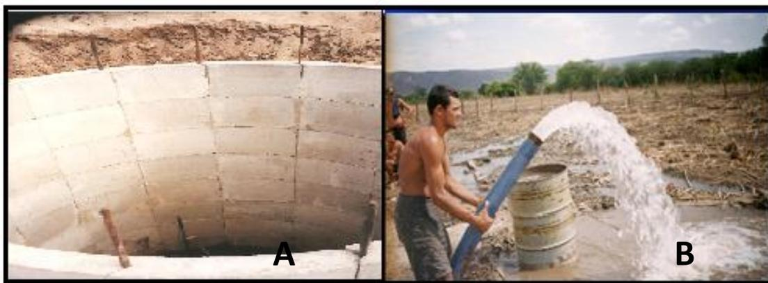
Foto 2 – (A) Blocos de concreto articulados para construção do poço
