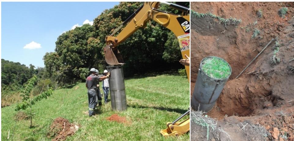
Figura 01: Cravação do lisímetro a), detalhes da escavação nas laterais do lisímetro b).
