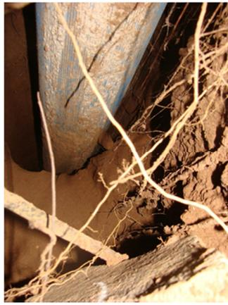
Figura 3 - Exemplo de falta de proteção sanitária/cimentação.
