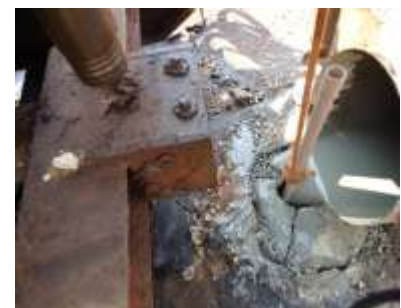
Figura 11 - Injeção da calda de cimento.
