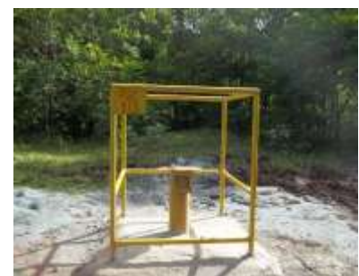
Figura 14 - Poço de Monitoramento Concluído.
