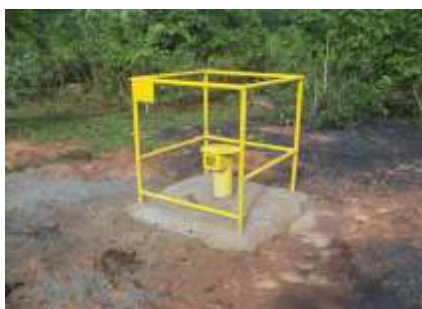
Figura 13 - Instalação da grade de proteção.
