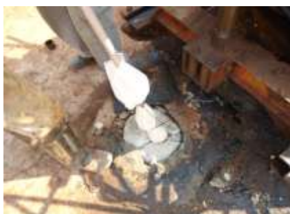
Figura 7 - Descida da Bucha de Compactolit.
