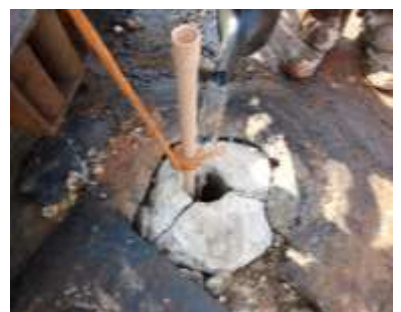
Figura 8 - Injeção de água para reação e travamento da bucha compactolit.
