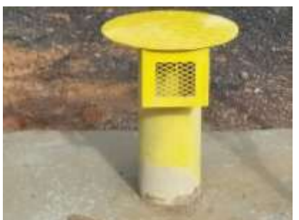
Figura 12 - Instalação tubo de boca de aço.
