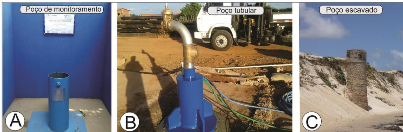
Figura 3 - Alguns tipos de poços identificados no campo: A) Poço de monitoramento, com proteção do tubo principal; B) Poço tubular para captação de água e abastecimento (Pedro Laurentino – Piauí); C) Poço escavado no litoral, sofrendo um processo erosivo em decorrência do avanço das marés (Litoral norte do Rio Grande do Norte, na região entre os municípios de Touros e Rio do Fogo).
