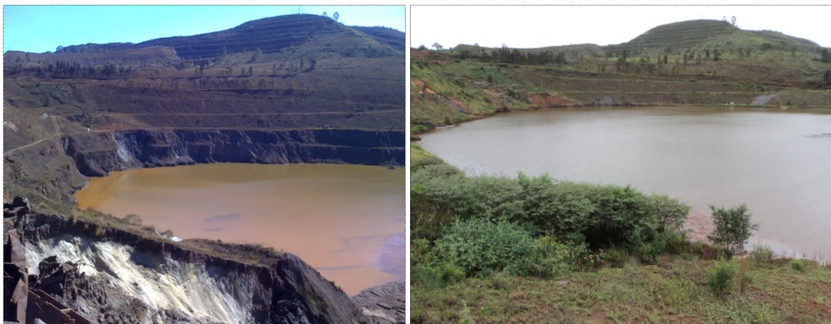
Figura 1. Cava Área IX (Em 2010 e 2014 respectivamente).
