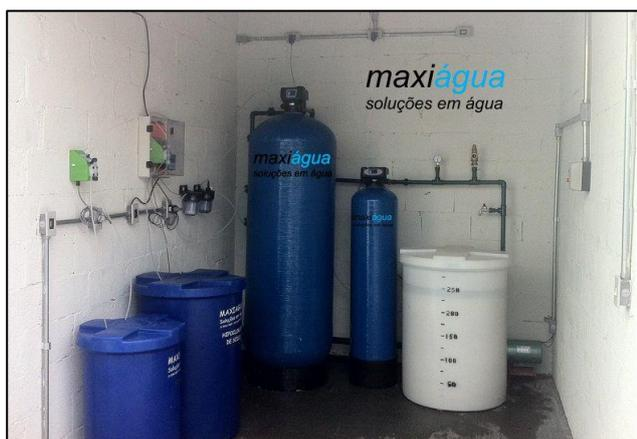
**Figura 9.** Sistema com pré-tratamento + 01 vaso
